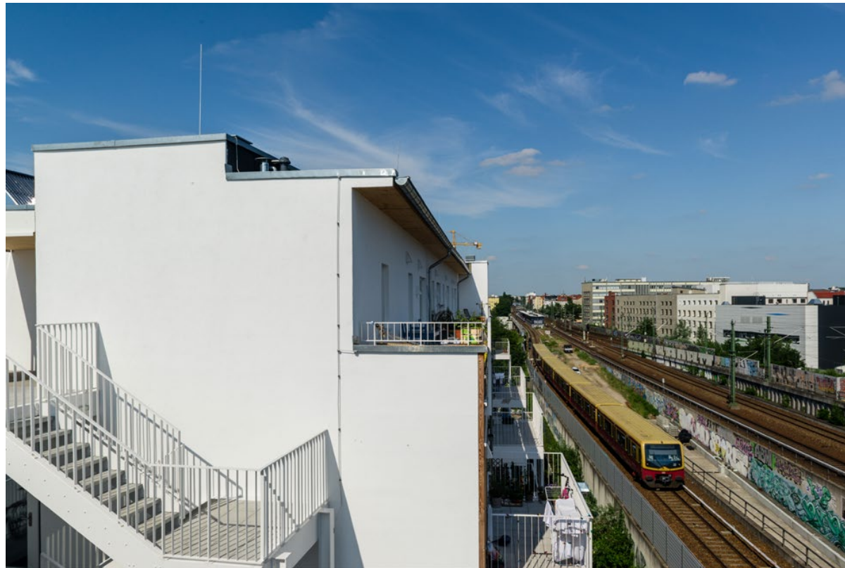
Wegen der bahnnahen Grundstückslage und der dort möglichen Lärmbelastung, mussten während der Planungsphase lange Verhandlungen geführt werden. Foto: Christian Frey
