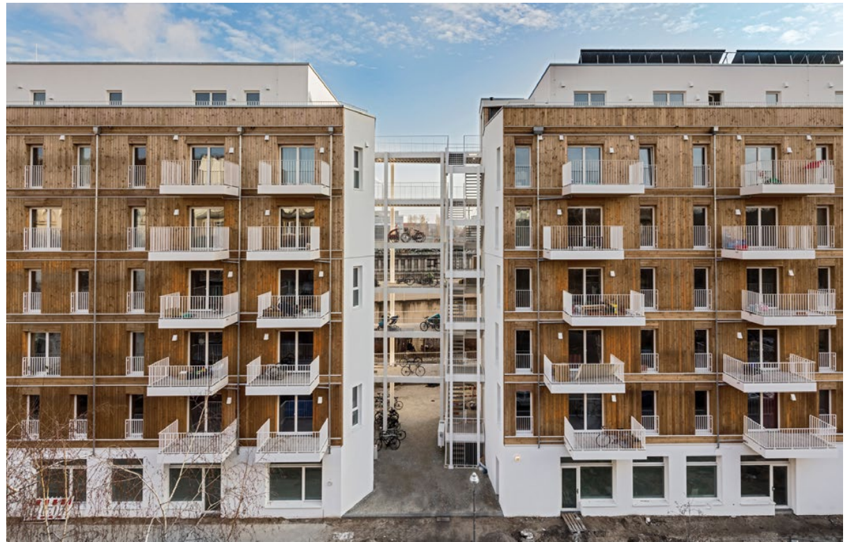
Trotz der drei Bauabschnitte gilt die neue Wohnstätte mit sozialen Funktionen im Erdgeschossbereich als ein Gebäude. Die Holzfassade aus Douglasie wird sich mit der Zeit gräulich verfärben. Foto: Markus Löffelhardt
